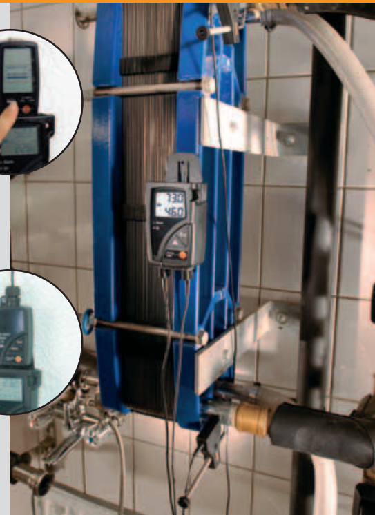
Control de sistemas técnicos (temperatura de flujo/re-torno) en plantas de producción
